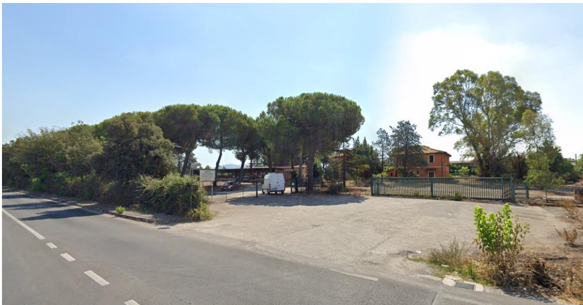
Foto accesso esistente su via di Ciampino
