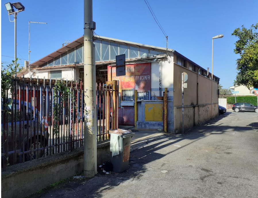
Foto accesso 2_AT.02 da via Leoncavallo (accesso Autofficina)
