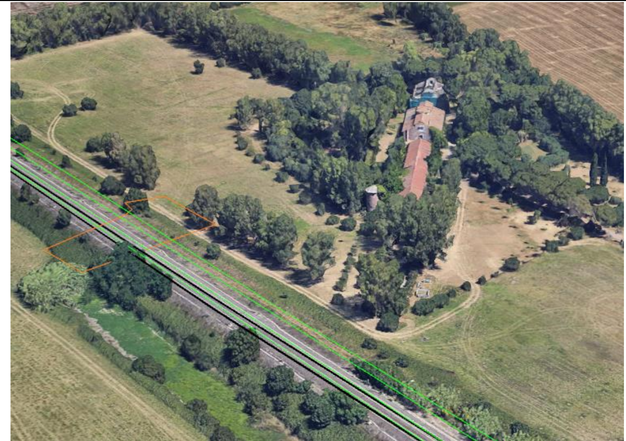
Figura 50 – Area tecnica AT07 in prossimità del casale mascherato dalla fascia alberata.
