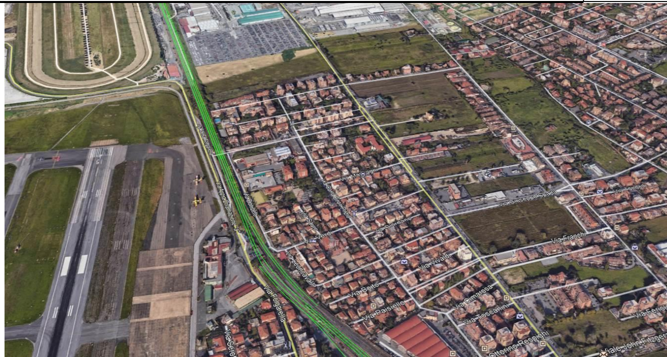
Figura 45 – Ripresa aerea con il tracciato ferroviario in progetto (in verde) e l'ingresso nel territorio di Ciampino. Fonte: Google earth.
