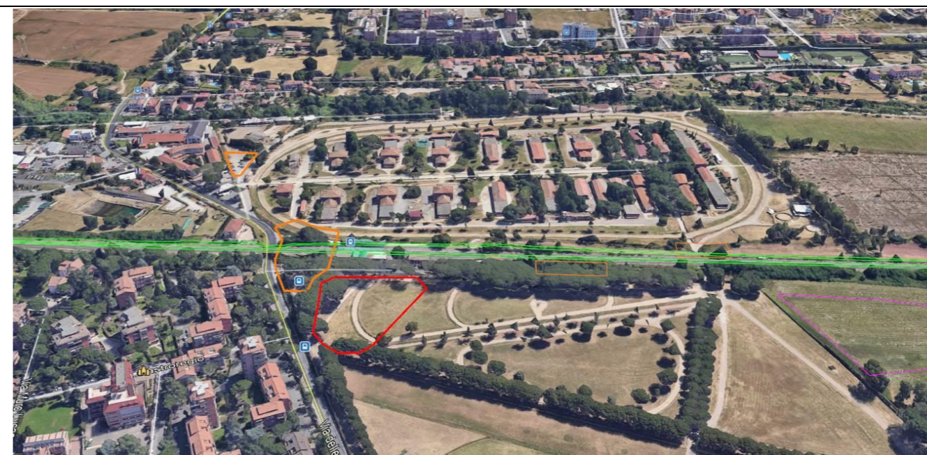
Figura 48 – Vista dell'area destinata ad ospitare il Cantiere Base CB01 (area rossa), futura area di parcheggio della nuova Stazione di Capannelle.
