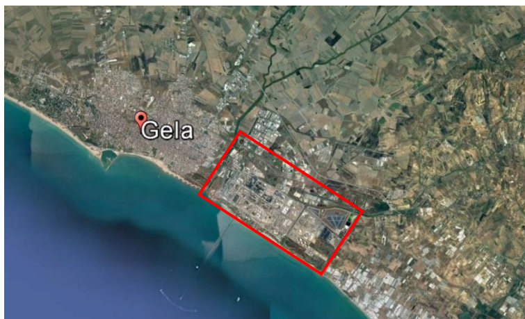
Figura 2-1: Inquadramento geografico dell'area industriale (in rosso) in cui ricade la Raffineria (fonte: Google Earth).
