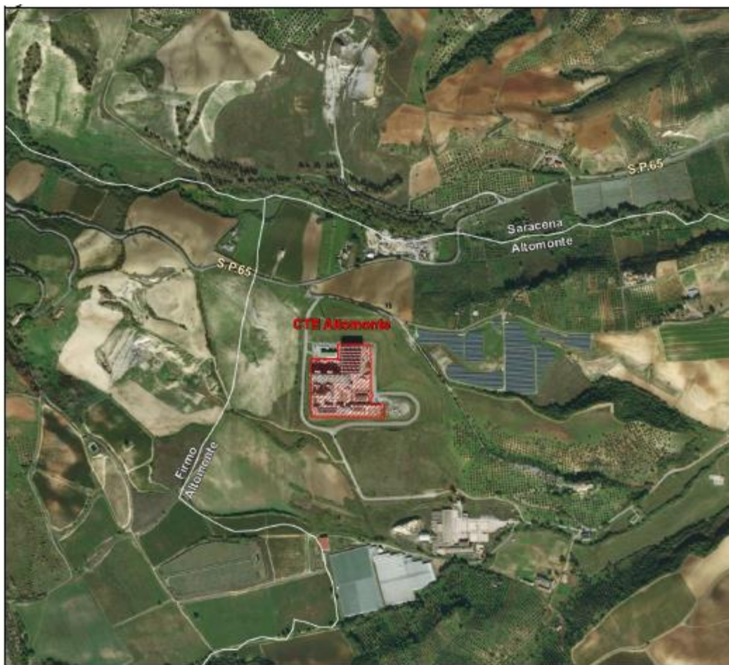
Figura 1: Localizzazione della Centrale Termoelettrica Edison su foto aerea
