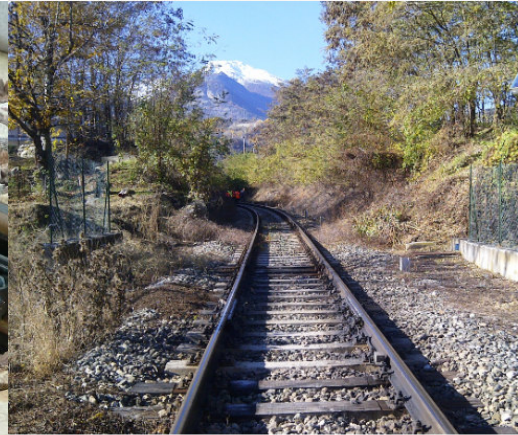
Impianto lubrificazione P.A.L. Italia (Foto: P.A.L. Italia; 2012)
