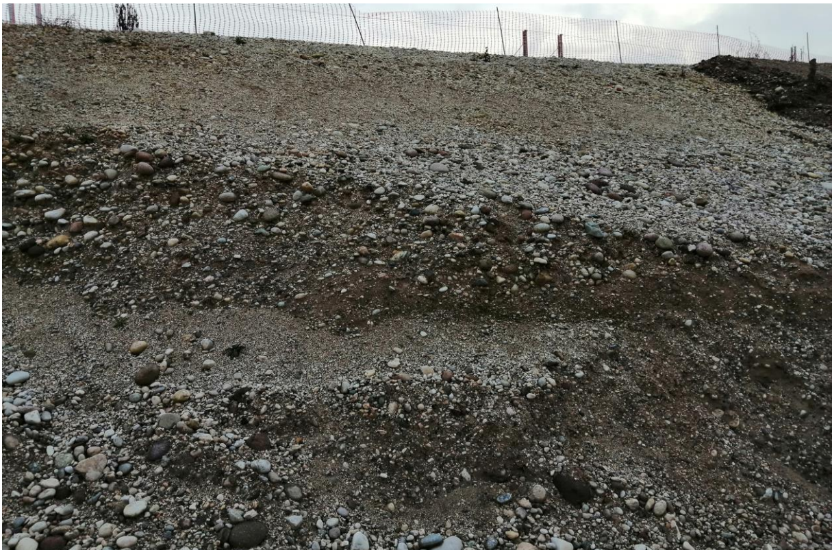
Figura 8. Sbancamento in Fg R2 1.
