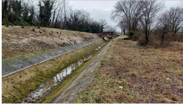
Figura 4 – Ponte sul canale San Giovanni allo stato attuale
