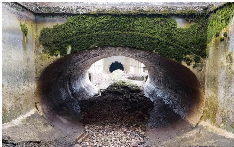
Figura 10 – Canale San Giovanni in corrispondenza del secondo attraversamento ferroviario (sez. 5.1 U-5.1D) e del primo tratto intubato (sez. 2.8)
