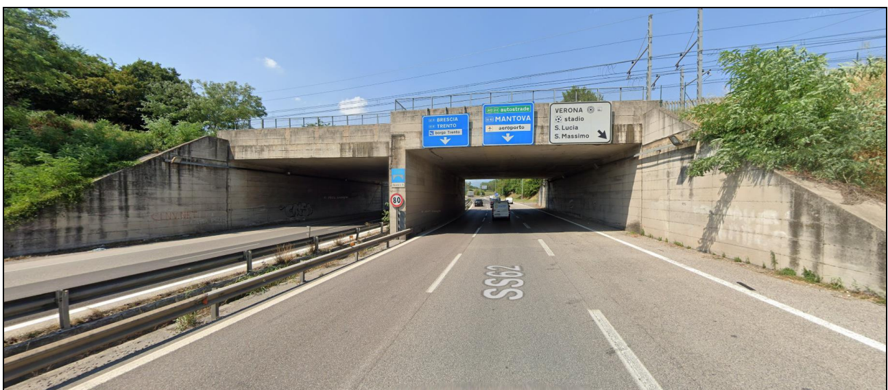
Figura 3 – Opera in oggetto – Sottovia km 142+111
