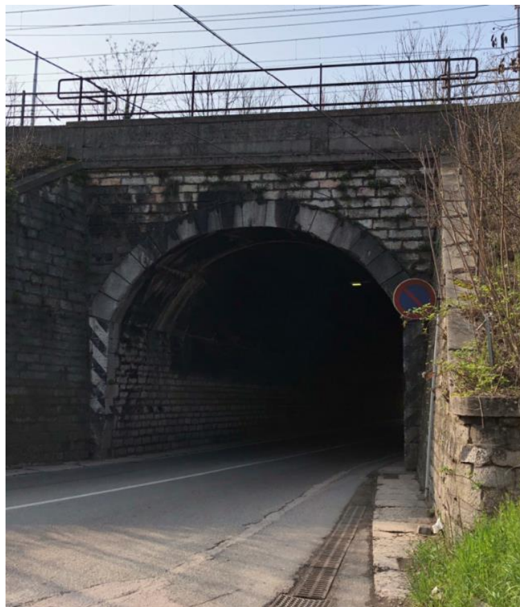
Figura 3 – Opera in oggetto – Sottovia km 145+425
