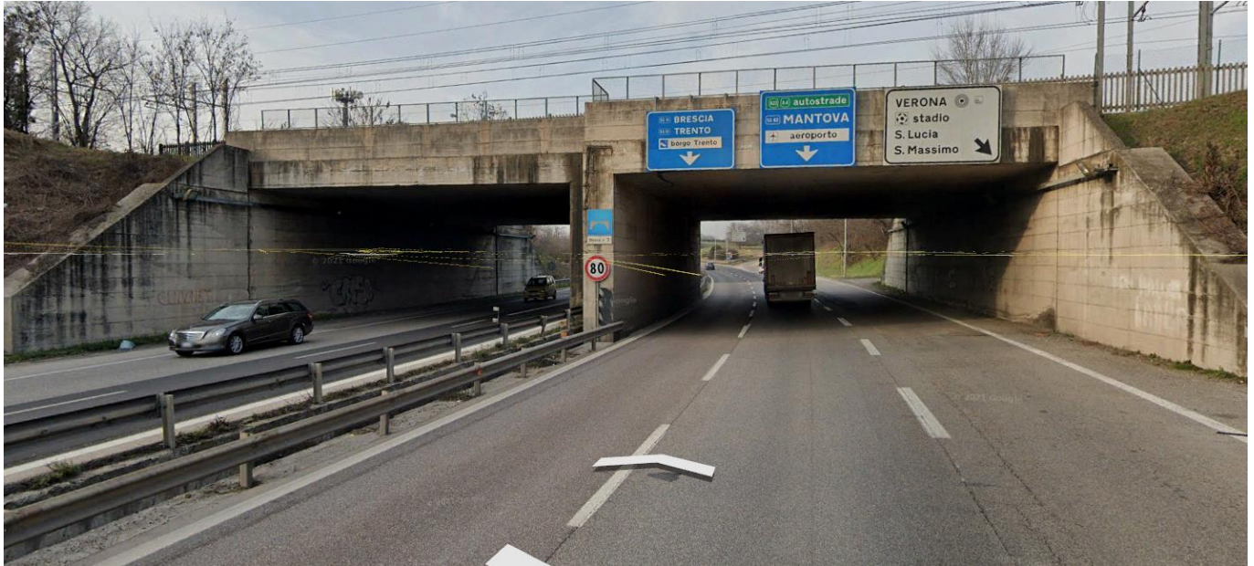
Figura 5 - Sottovia tangenziale – Punto di presa Sud-Ovest nelle vicinanze dell’imbocco del manufatto ovest
