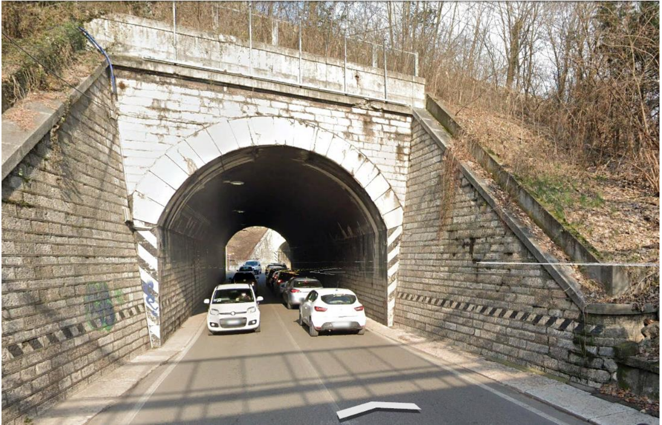
Figura 4 - Sottovia tangenziale – Punto di presa Sud-Ovest nelle vicinanze dell’imbocco del manufatto ovest
