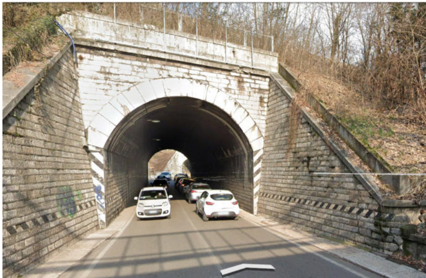
Figura 48 – Sottopasso Via Albere Nord – Punto di presa Sud-Ovest nelle vicinanze dell'imbocco del manufatto ovest
