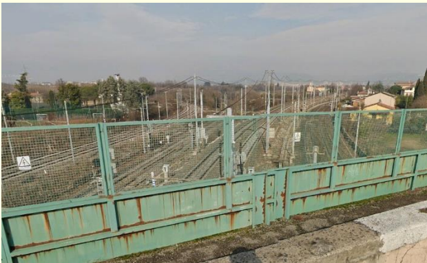
9a. Vista da via Sommacampagna nel punto in cui la viabilità sovrappassa la linea ferroviaria: il punto di osservazione è in direzione dell'infrastruttura ferroviaria. Vi sono numerosi elementi visibili che popolano il quadro scenico e riducono la capacità dell'osservatore di individuare nuovi elementi introdotti che quindi risulta "assorbiti" dal contesto paesaggistico.
