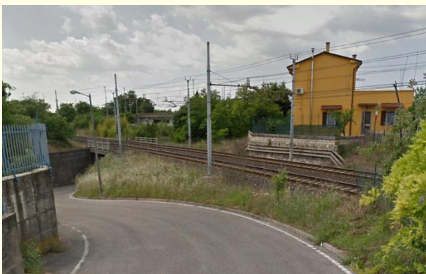
7. Vista da via Brigata Casale in direzione del sottovia Km 1+218.30 e della linea ferroviaria.
