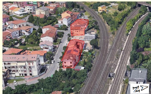
Vista 3D di Via Brigata Casale (a sinistra) e della linea ferroviaria (a destra). Le abitazioni prospicienti rappresentano luoghi di fruizione statica (indicate in rosso).
