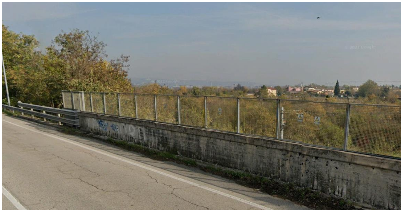
Figura 4-5: Nucleo arboreo – arbustivo lungo la sede ferroviaria in corrispondenza del tratto finale del cavalcaferrovia di via Fenilon
