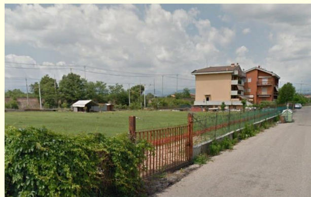
8. Vista da Brigata Cuneo: dal punto di osservazione, la linea ferroviaria risulta percepibile attraverso i soli elementi della linea elettrica.
