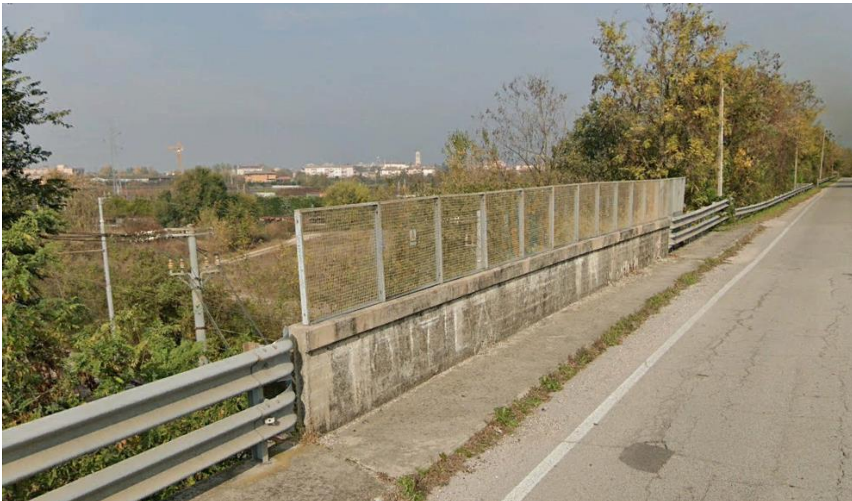
Foto 11: Vista, in direzione nord, dall'attuale cavalcafferovia di Via Fenilon. Nella vista sono visibili la vegetazione lungo la viabilità e, sulla sinistra, l'area in cui è prevista la nuova SSE
