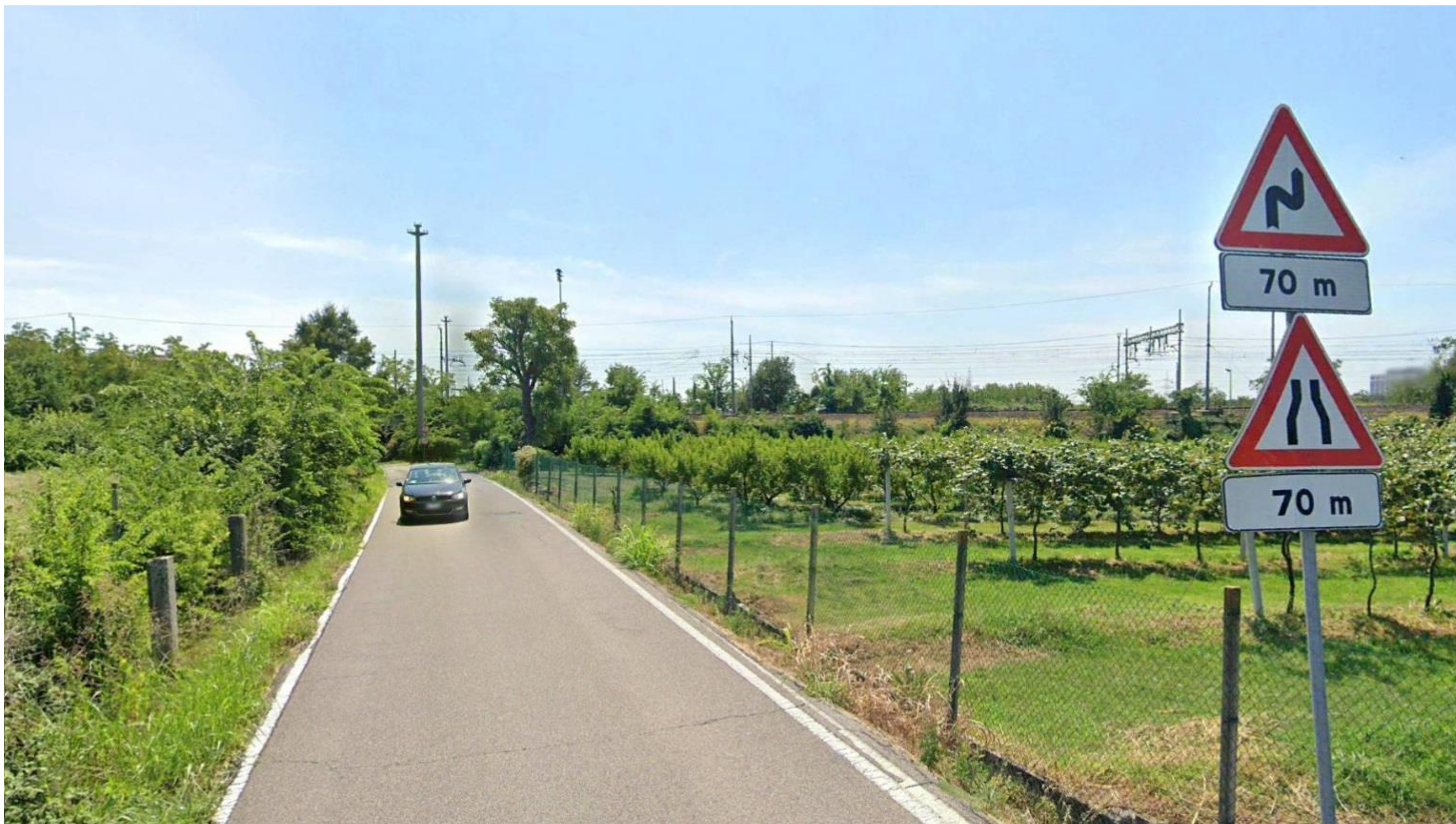
Foto 8: Veduta verso Sud, da Via Carnia, del tratto attraversato dall'intervento in cui la linea di progetto verrà realizzata parallelamente al sedime della linea ferroviaria esistente, attraversando i terreni utilizzati per le colture arboree
