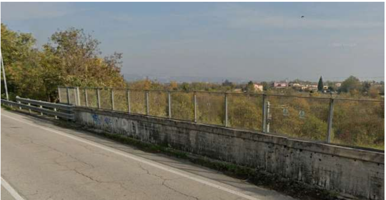
Figura 7-7: Nucleo arboreo – arbustivo lungo la sede ferroviaria in corrispondenza del tratto finale del cavalcaferrovia di via Fenilon
