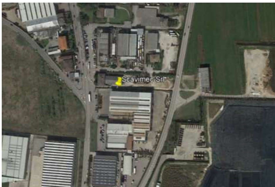
Figura 5-2: Impianto di recupero Scavi Mec S.r.l., foto aerea
