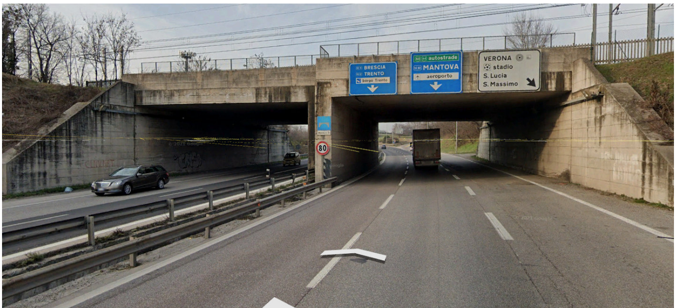
Sottovia tangenziale – Punto di presa Sud-Ovest nelle vicinanze dell'imbocco del manufatto ovest
