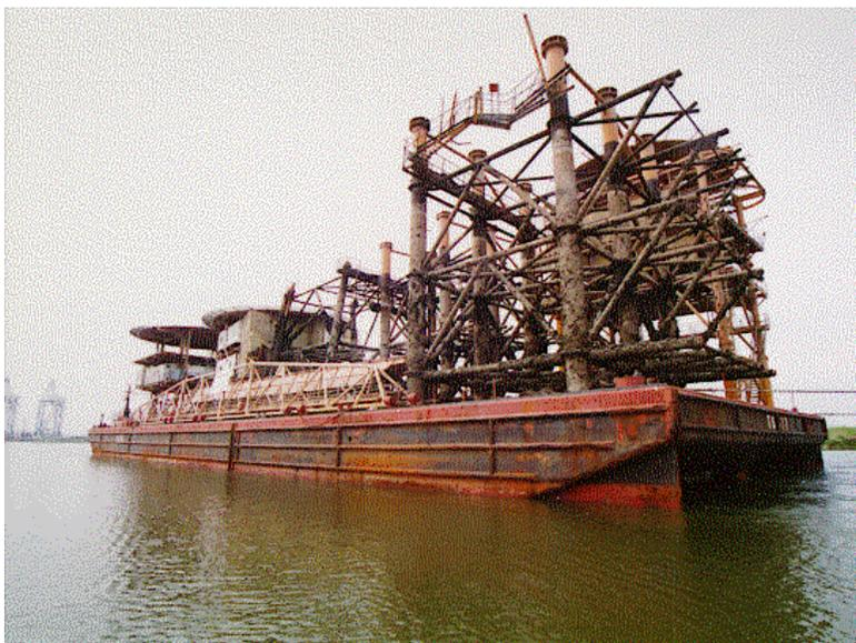
Fig 34 Trasporto delle Strutture Rimosse
