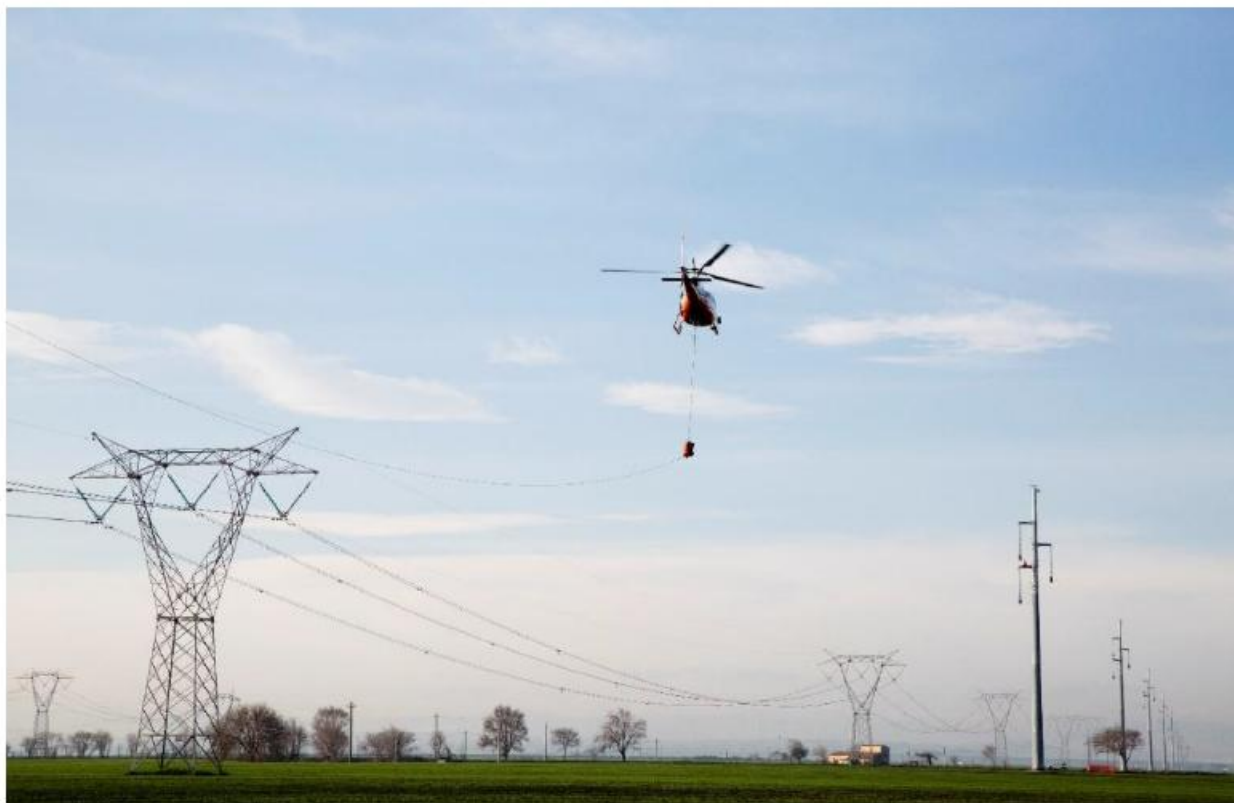
Figura 3-17: Utilizzo dell'elicottero per la stesura della fune pilota
