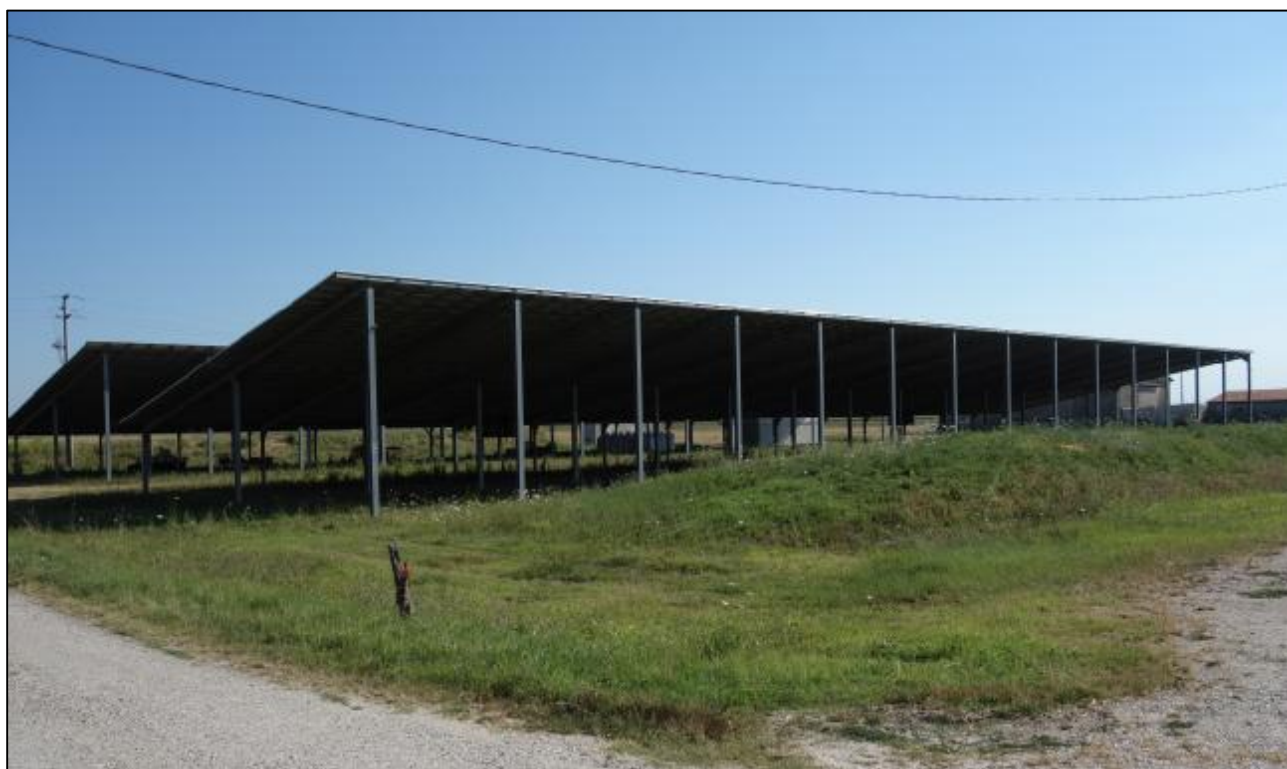
Figura 6-71: A sinistra: vista della stazione Snam esistente. A destra: vista delle due strutture a pannelli fotovoltaici. Punti di osservazione lungo la SP8 (rispettivamente: 1 e 2), indicati dalle frecce in Figura 6-70.
