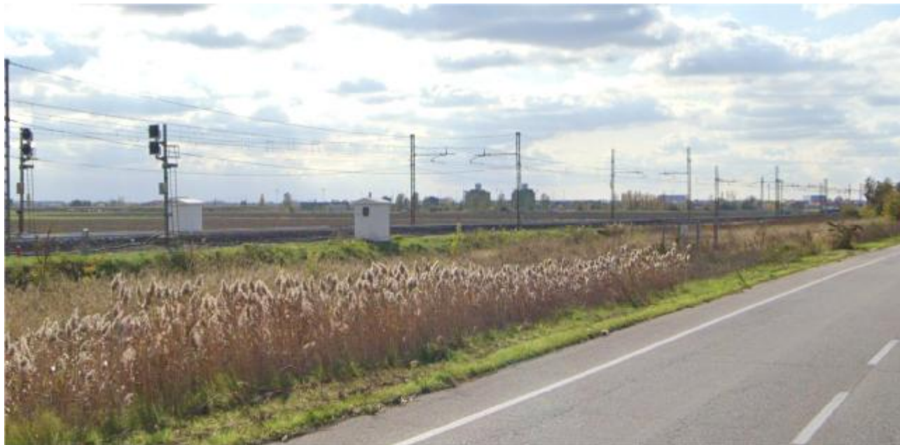
Figura 2-8: Punto 6 - Vista della Centrale di compressione da SP70
