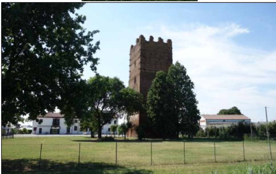
Figura 6-65: Alcune immagini della Torre dell'Uccellino e della corte limitrofa.
