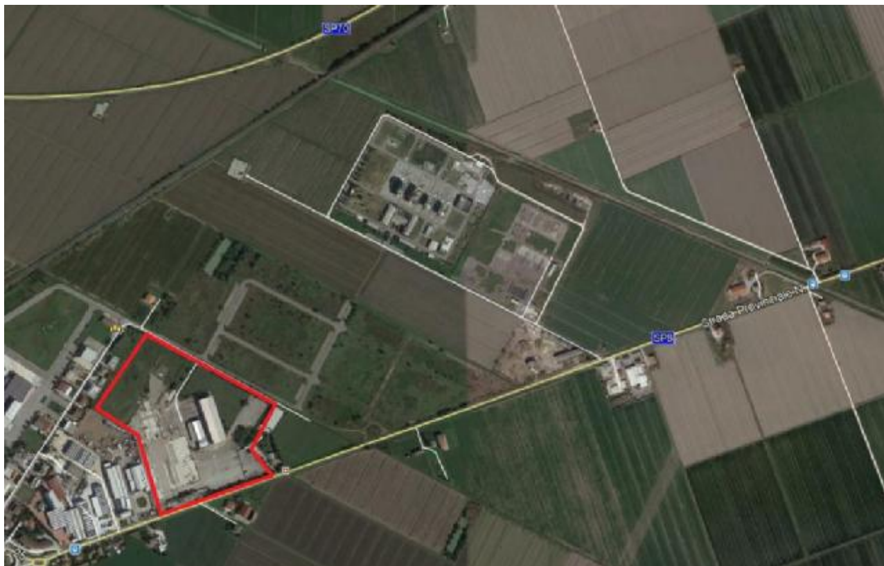
Figura 3-12: Area di cantiere temporanea esterna al sito SNAM
