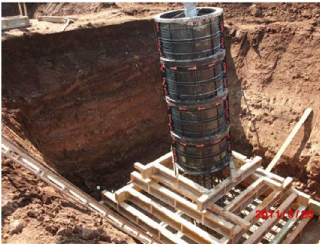
Figura 3-14: Esempio di realizzazione di una fondazione a plinto con riseghe. Nell'immagine si può osservare un disegno di progetto mentre nell'immagine di destra la fase di casseratura della fondazione (in alto); realizzazione di fondazioni superficiali tipo CR per un sostegno a traliccio. Nell'immagine si può osservare la fase di casseratura (in basso)
