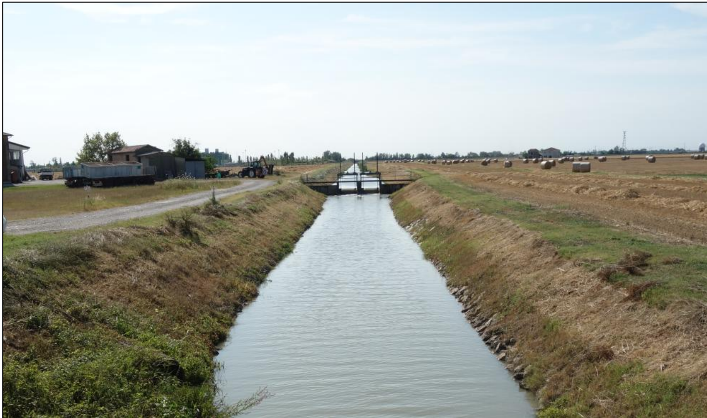
Figura 6-62: Vista dello Scolo Principale del 3° Circondario intercettato lungo SP8 dal tratto di elettrodotto in progetto. Lo scolo è di forma regolare, caratterizzato da opere di attraversamento, chiuse e tombinamenti in calcestruzzo, e non presenta vegetazione ripariale a medio-alto fusto.
