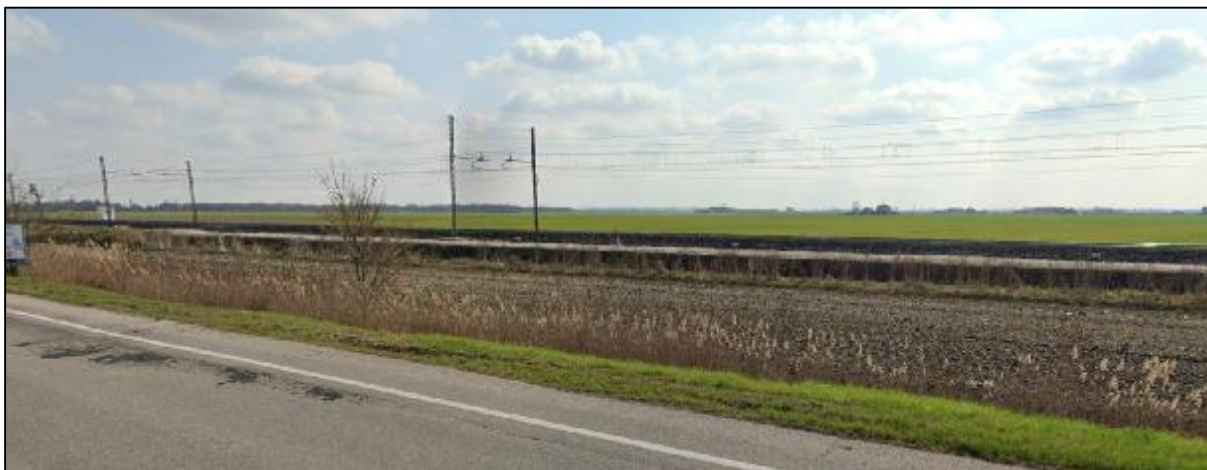
Figura 6-75: Vista della ferrovia e dell'area oggetto di intervento dalla SP70
