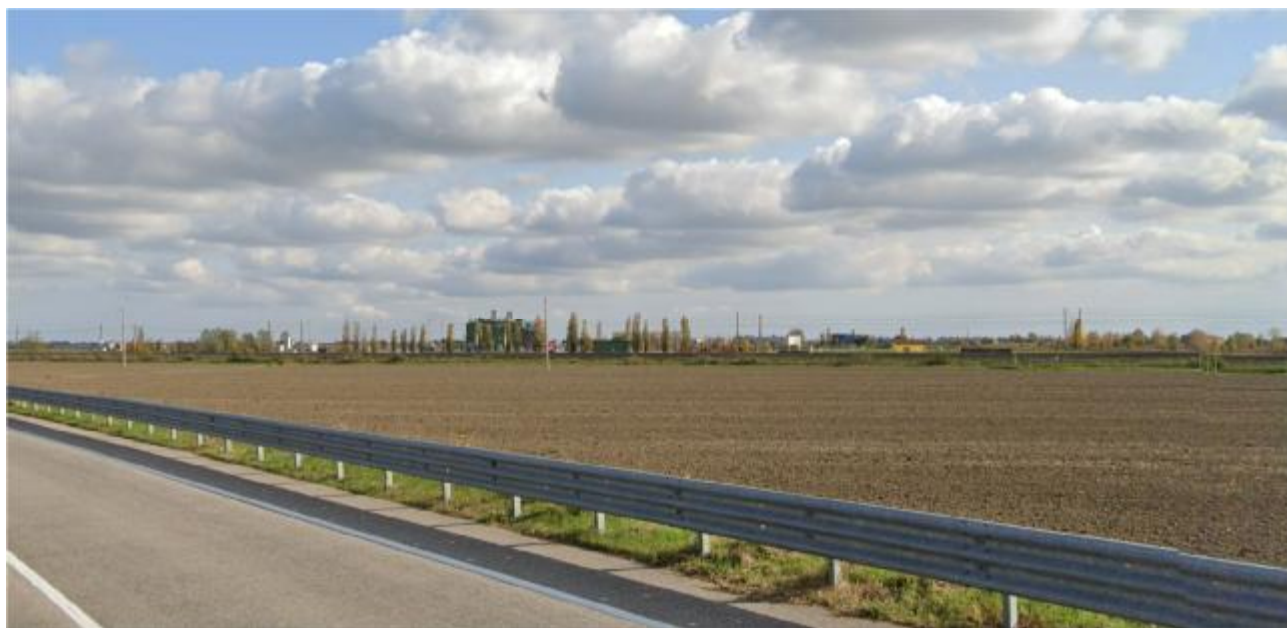
Figura 2-7: Punto 5 - Vista della Centrale di compressione da SP70
