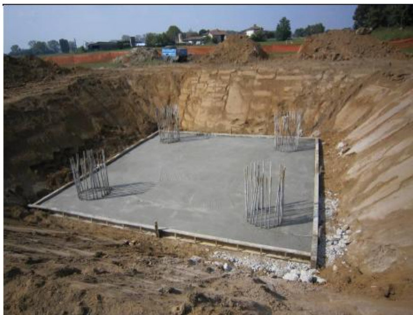
Figura 3-15: Realizzazione di una fondazione su pali trivellati per un sostegno monostelo. Nell'immagine si può osservare una fondazione in fase di realizzazione. si possono distinguere facilmente i quattro pali trivellati già realizzati e gettati (si osservano le prese delle quattro gabbie metalliche) e del piano di magrone sul quale impostare il monoblocco in cls
