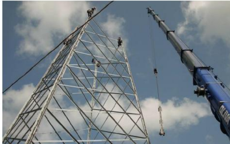
Figura 3-16: Fasi di montaggio sostegno a traliccio
