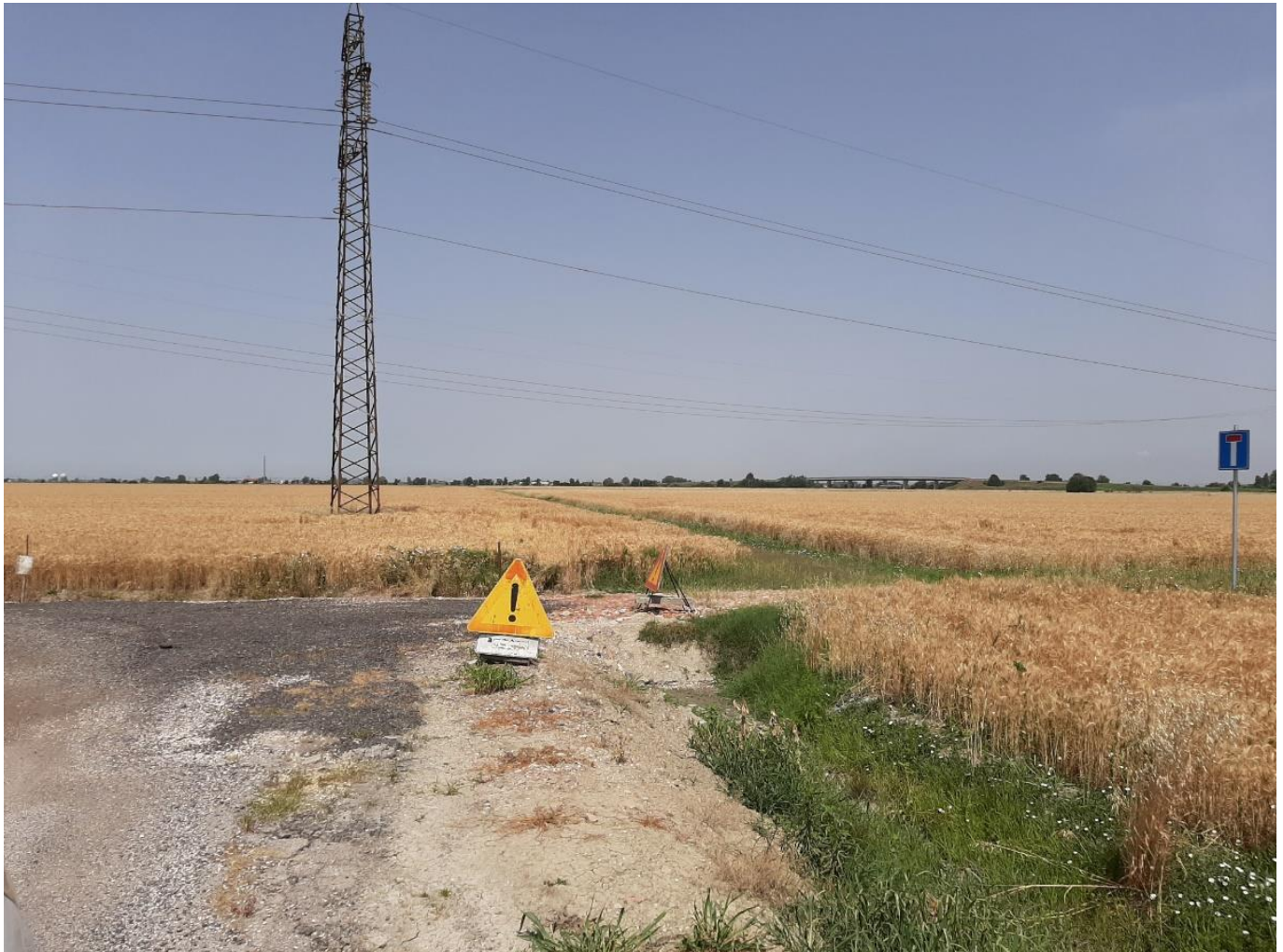
Figura 2-3: Stato di fatto del sito della stazione RTN e della sottostazione utente.
