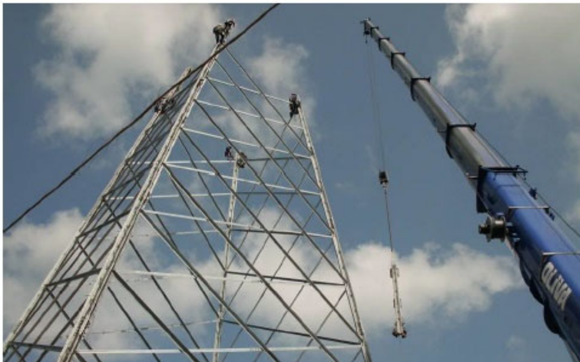
Figura 2-13: Fasi di montaggio sostegno a traliccio
