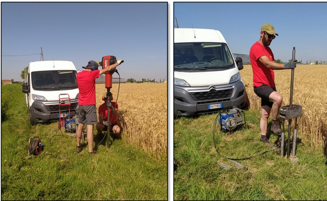
Figura 17 – Strumentazione utilizzata per realizzare i microsondaggi: Martellone demolitore (foto a sinistra) ed estrattore (figura a destra).
