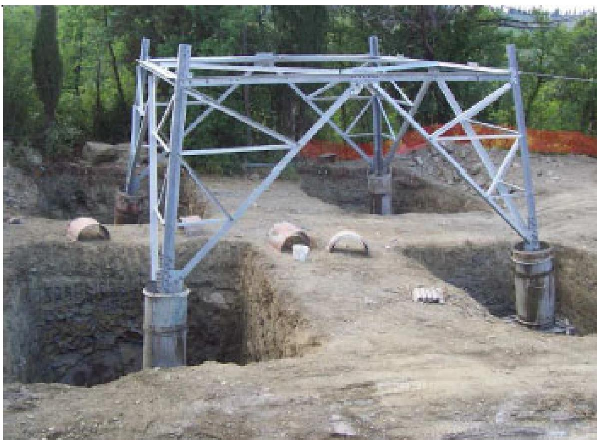
**Figura 14: Realizzazione di fondazioni superficiali tipo CR per un sostegno a traliccio. Nell'immagine si possono osservare le quattro buche, la base del sostegno collegata alla fondazione tramite i "monconi" ed i casseri utilizzati per quattro "colonnini"**
