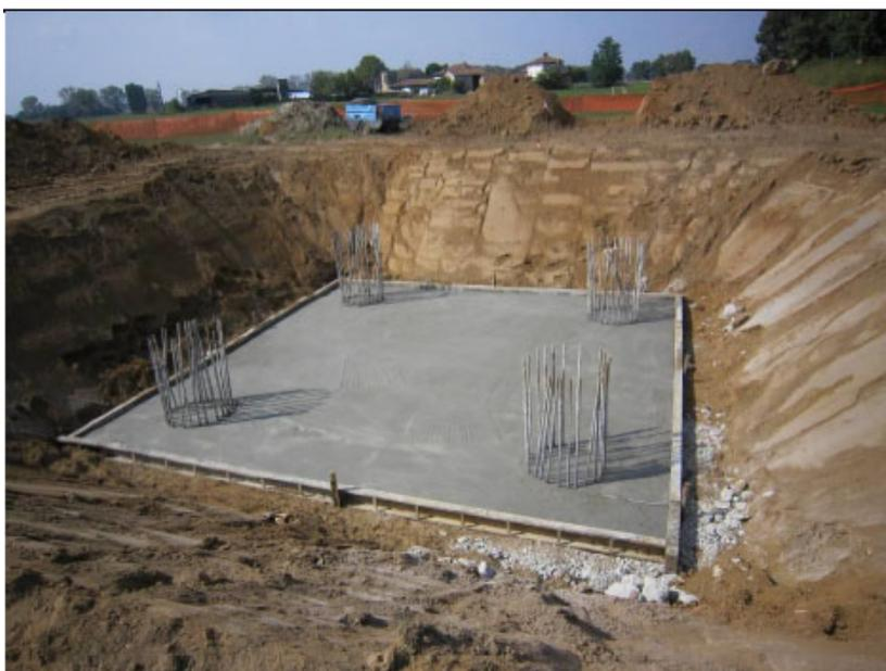
**Figura 16: Realizzazione di una fondazione su pali trivellati per un sostegno monostelo. Nell'immagine si può osservare una fondazione in fase di realizzazione. si possono distinguere facilmente i quattro pali trivellati già realizzati e gettati (si osservano le prese delle quattro gabbie metalliche) e del piano di magrone sul quale impostare il monoblocco in cls**
