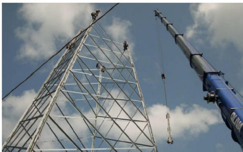
**Figura 17: Fasi di montaggio sostegno a traliccio**
