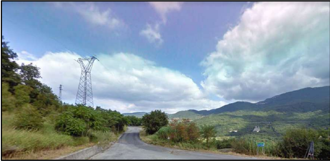
Fig. 4 – Panoramica del versante sinistro del F. Sangro (traliccio n.3)
