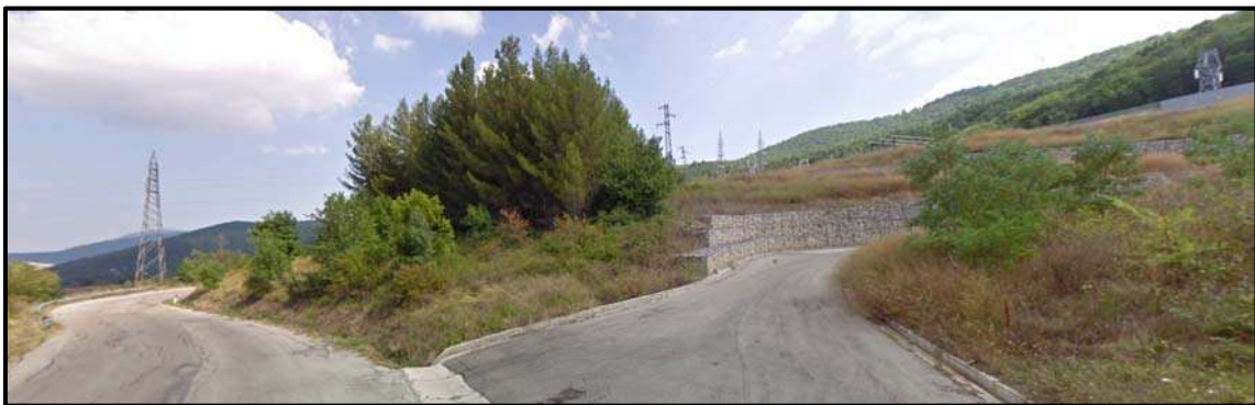
Fig. 5 – Panoramica del traliccio n.14 e della Sottostazione di Monteferrante
