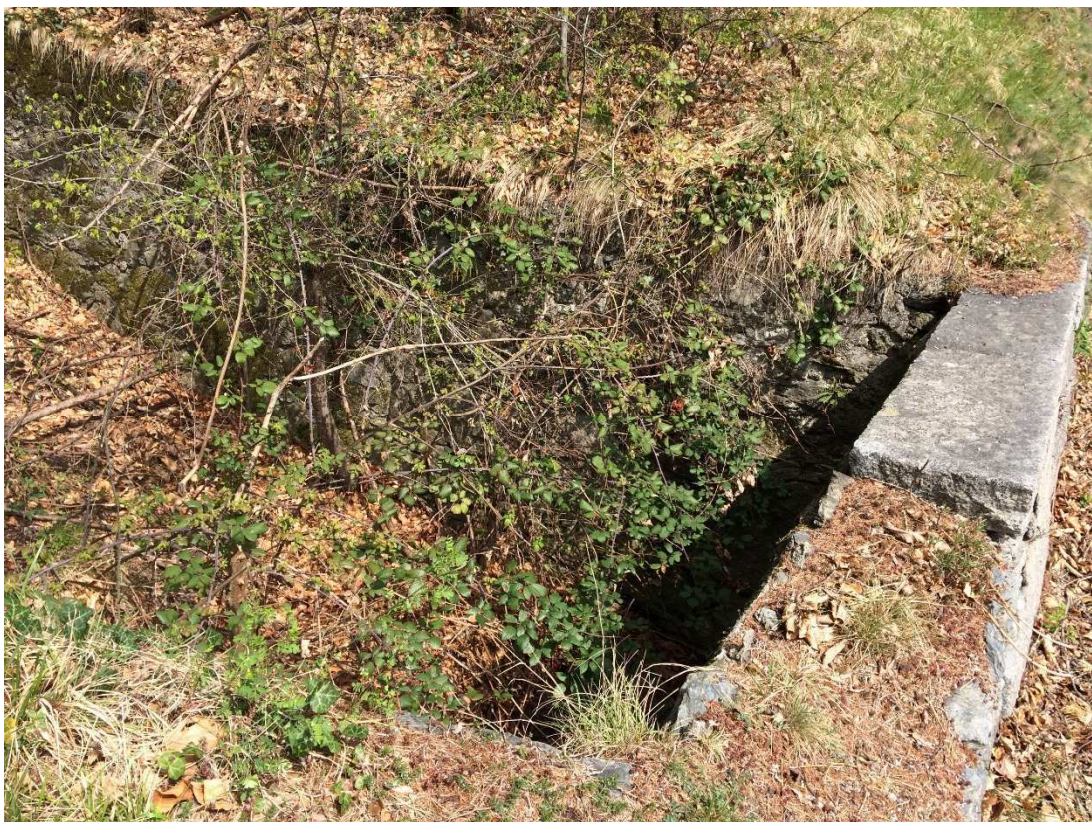
Figura 3 – Impluvio a monte della rotatoria nord
