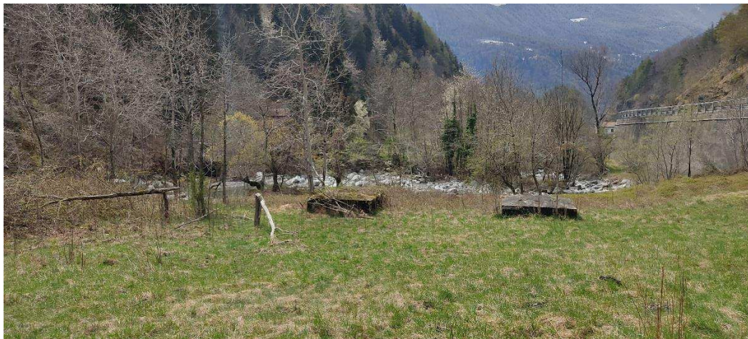
Fotografia 2: Area di espansione delle piene in destra idrografica, sedime del nuovo svincolo in progetto.
