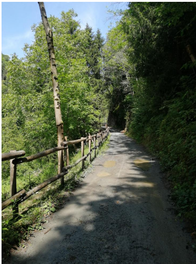
Figura 11 – Strada locale esistente
