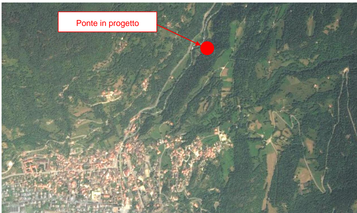
Figura 1 – Ponte sul Fiume Oglio – Ubicazione
