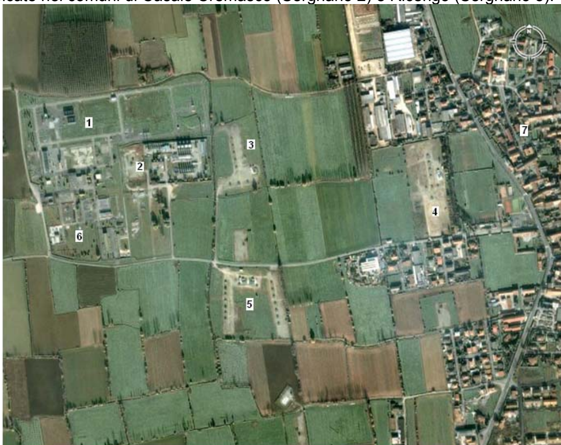
Fig. 1.1.a – Infrastrutture della Concessione Sergnano Stocaggio: (1) area compressione; (2) area trattamento; (3) cluster B; (4) cluster D; (5) cluster A e C; (6) area SnamReteGas; (7) centro abitato di Sergnano (base: immagine satellitare)
