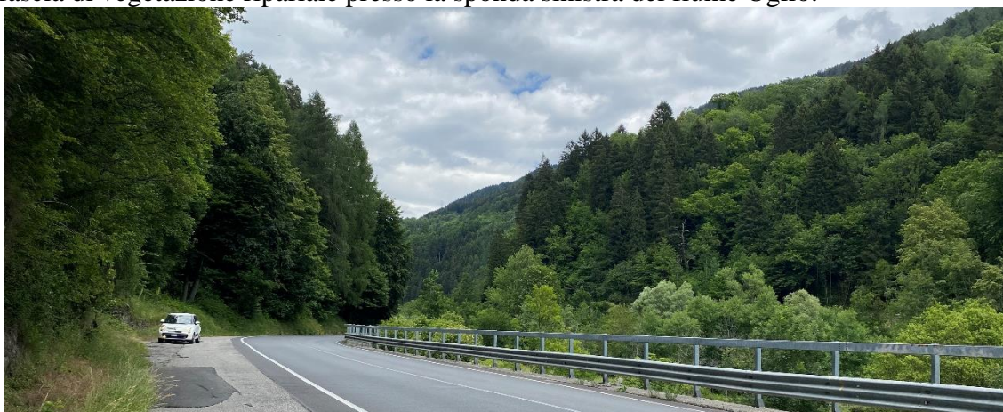
Figura 12 – Inquadramento del versante in destra idrografica in corrispondenza della rotatoria in progetto.
