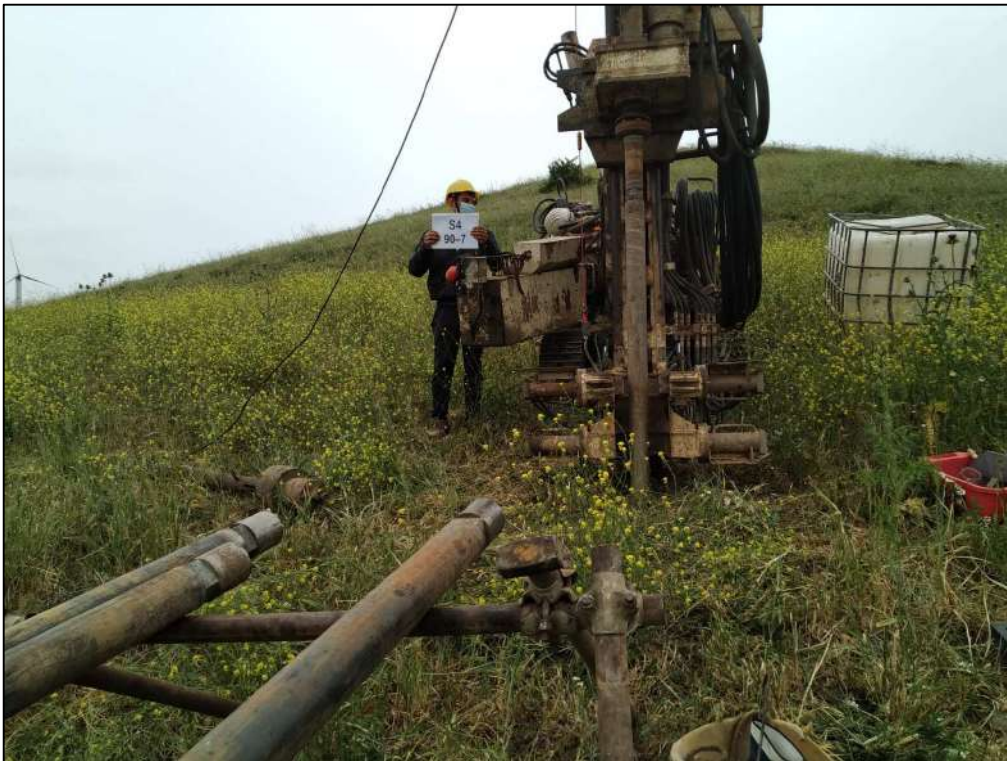
Figura 2 Foto sondaggio sostegno 90-7
