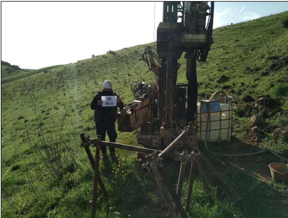
Figura 2 Foto sondaggio sostegno 90-5
