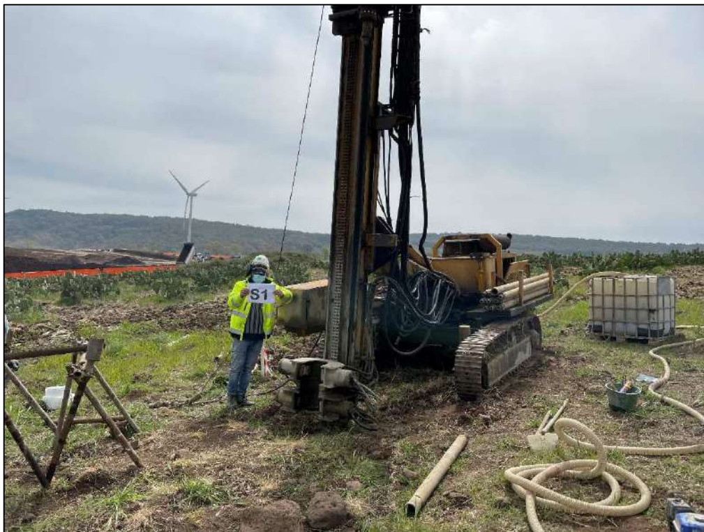
Figura 2 Foto sondaggio sostegno 80-6
