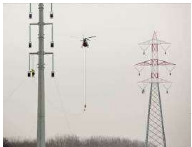
Utilizzo dell'elicottero per la stesura della fune pilota
