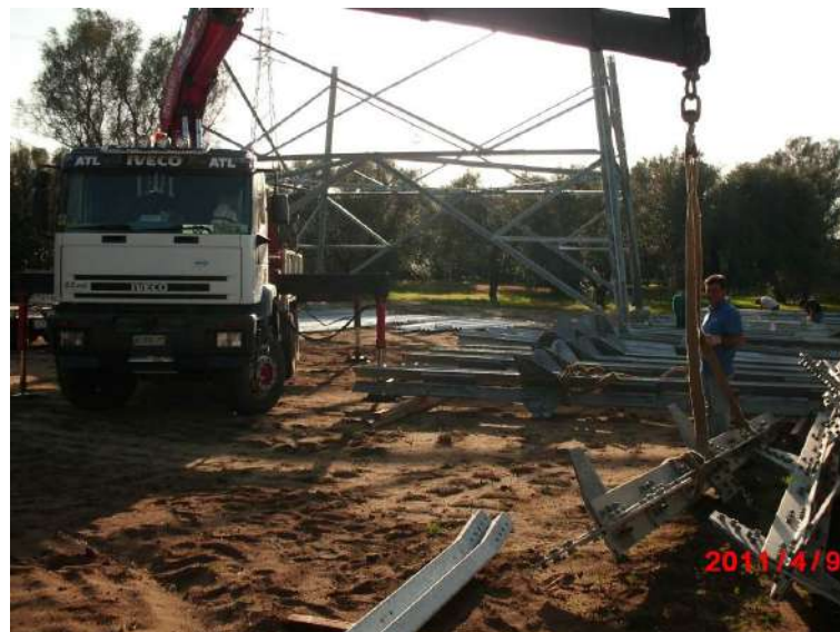
Fasi di montaggio sostegno a traliccio
