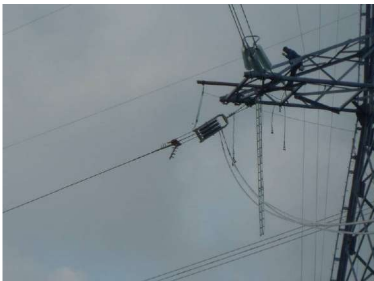
Fasi di tesatura della linea elettrica
