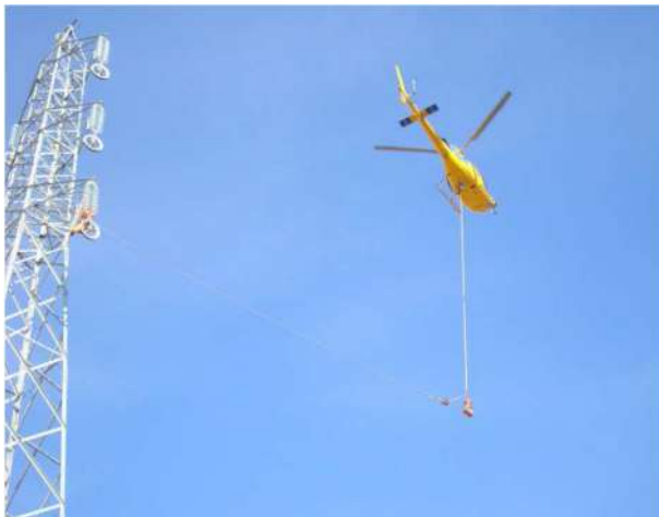
Utilizzo dell'elicottero per la stesura della fune pilota
