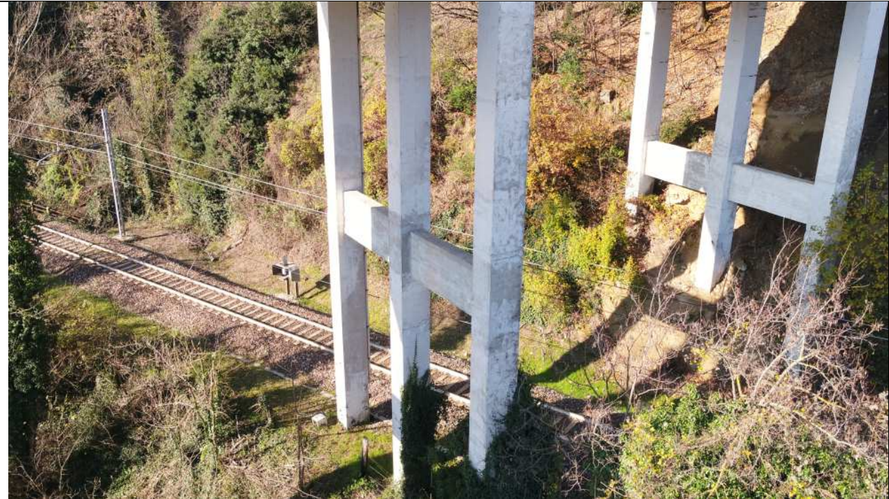
Pile attuali, a ridosso del binario della ferrovia "Porrettana"
