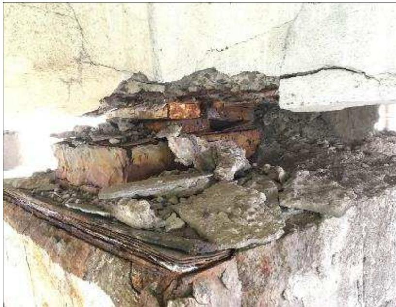
Figura 3: Appoggio dell'impalcato sulla pila 15: è visibile la perdita pressoché totale delle condizioni di appoggio, nonché l'ammaloramento delle superfici in calcestruzzo nella zona di contatto
