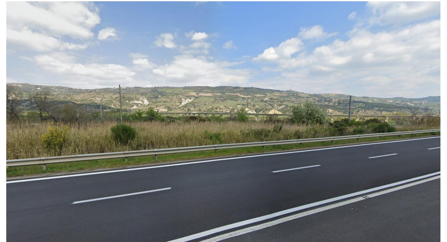
PUNTO 1 – VISTA DA VIABILITÀ PRINCIPALE (SS7)
