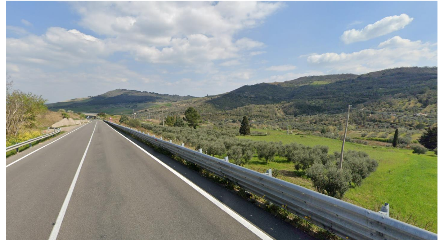
PUNTO 1 – VISTA DA VIABILITÀ PRINCIPALE (SS7)
