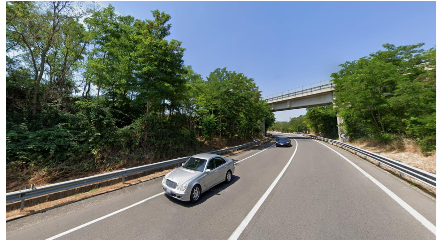
PUNTO 1 – VISTA DELL'AREA TECNICA AT.22 DALLA SS7
