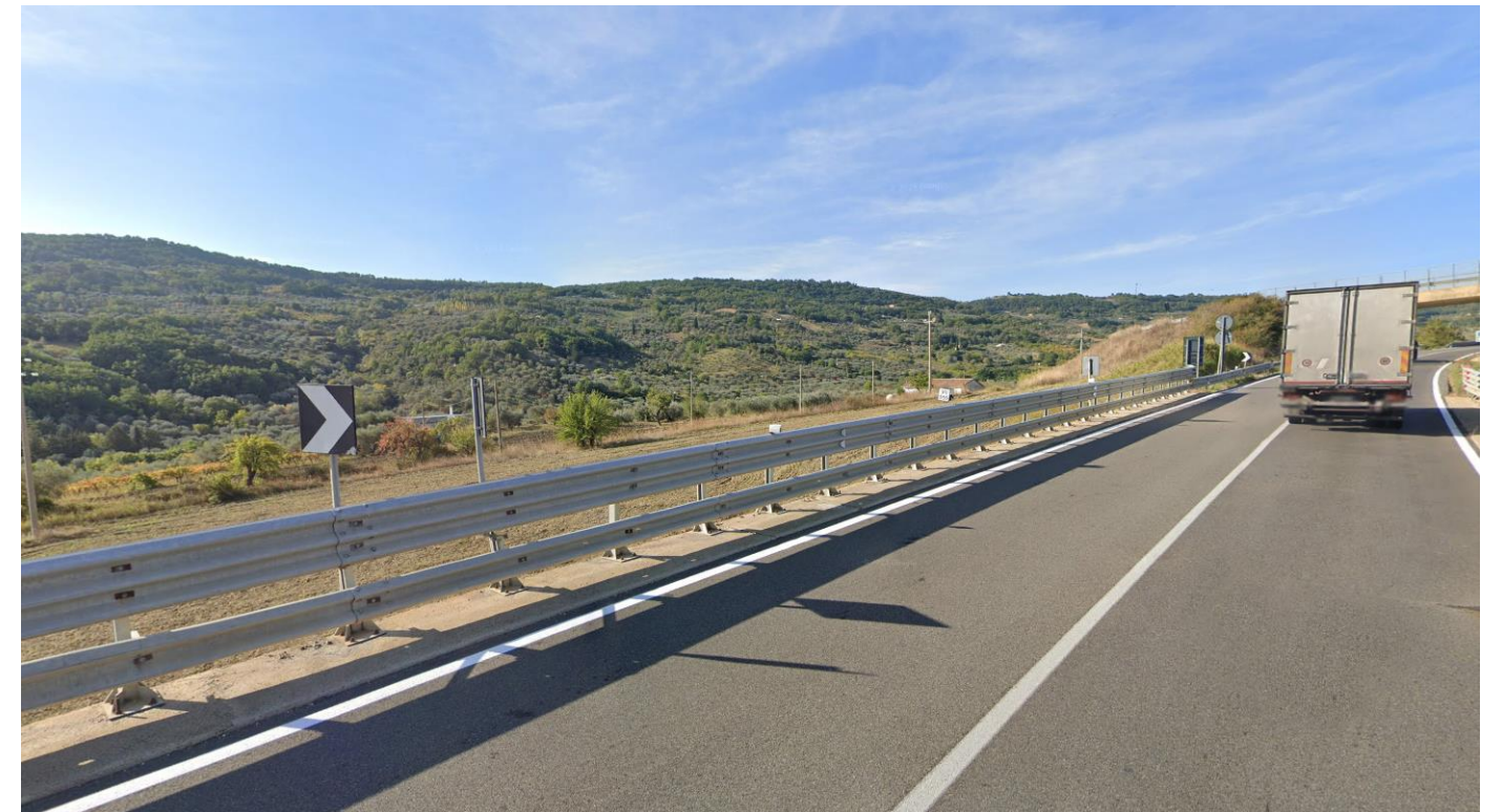
PUNTO 2 – VISTA DA VIABILITÀ PRINCIPALE (SS7)
