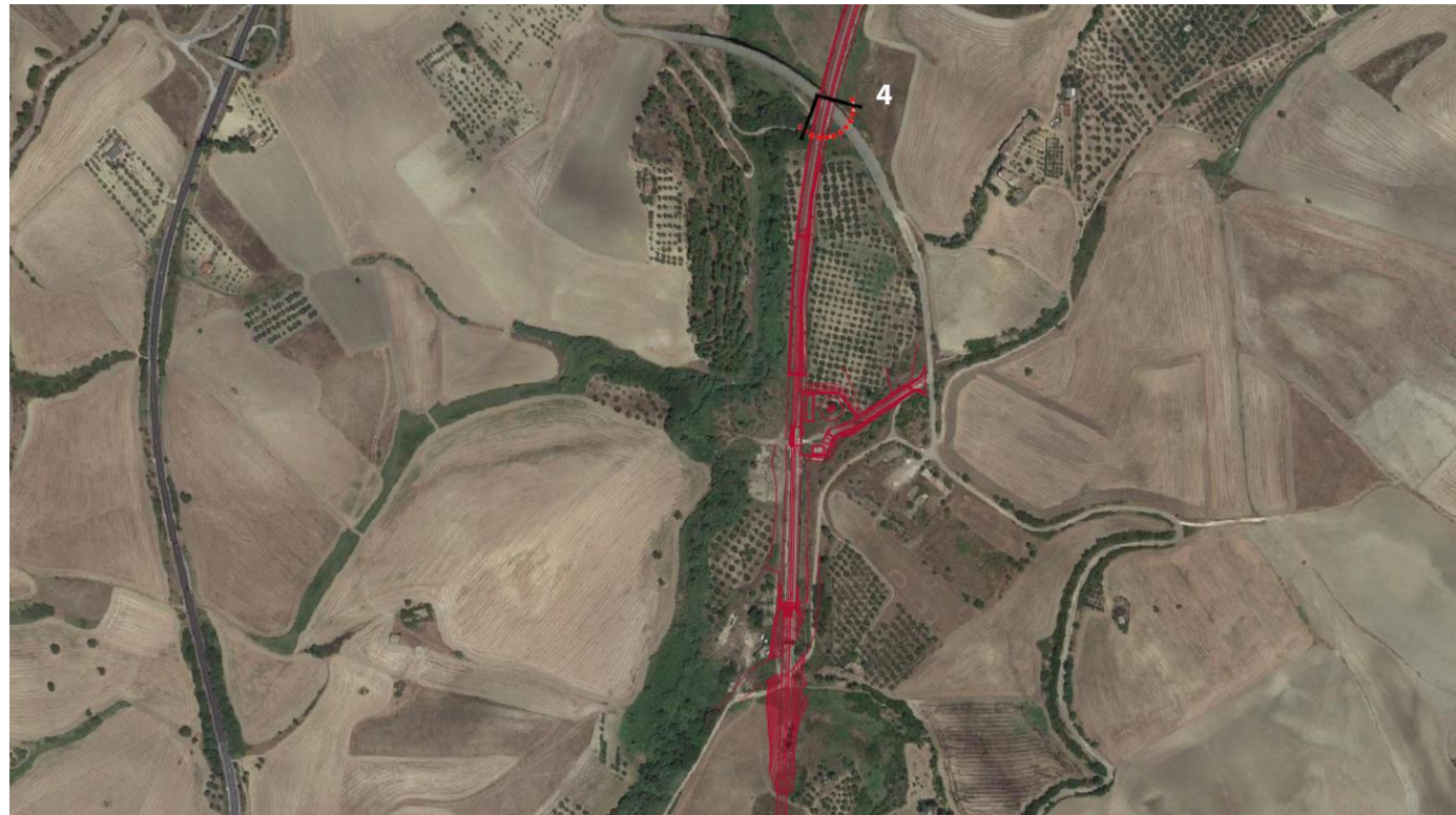
INQUADRAMENTO DELLA FOTOSIMULAZIONE RELATIVA ALL'IMBOCCO DI GALLERIA GA02, PRESSO MIGLIONICO (MT), RICADENTE NELLA FASCIA DI RISPETTO DEL FOSSO PORSARO, DEL RIO CONCHE E DEL FOSSO S.ANDREA PETROLLA; PUNTO DI VISTA DALLA SP211
