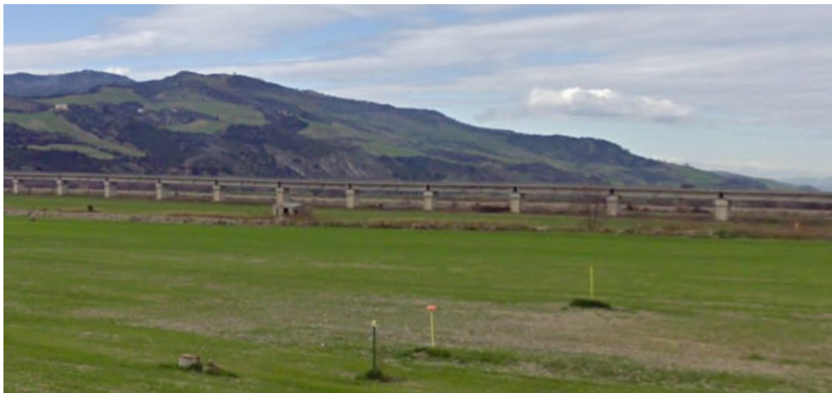
FIGURA 10 RILIEVO FOTOGRAFICO OPERE GIÀ REALIZZATE – VIADOTTO IN AMBITO AGRICOLO
