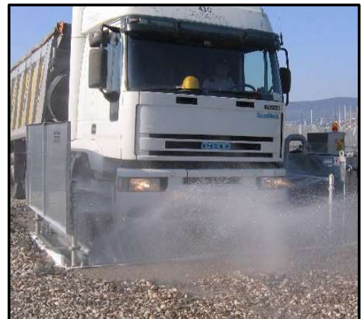
Figura 2: Esempio di mezzi utilizzati in cantiere per abbattimento delle emissioni di polvere
