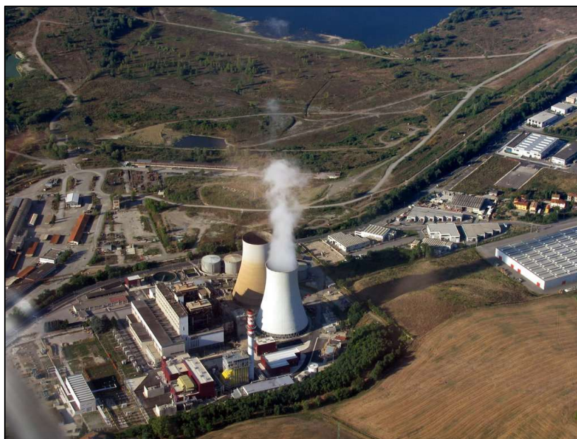
Figura 8. Vista della Centrale termoelettrica di Santa Barbara
