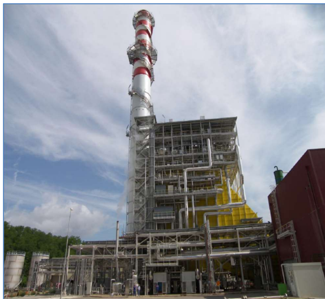
Figura 1. Vista dell'Unità SB3 della Centrale Termoelettrica di Santa Barbara.
