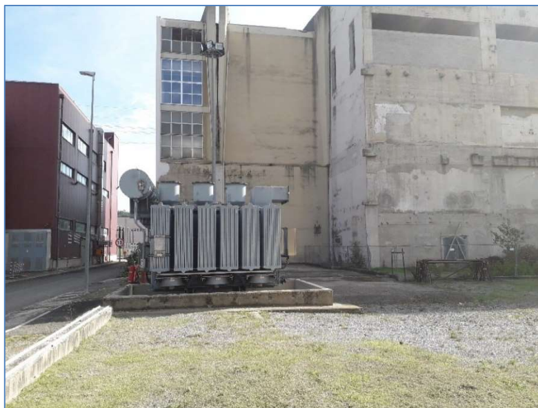
Figura 13. Area del nuovo edificio stoccaggio NH 3 e trasformatore da ricollocare
