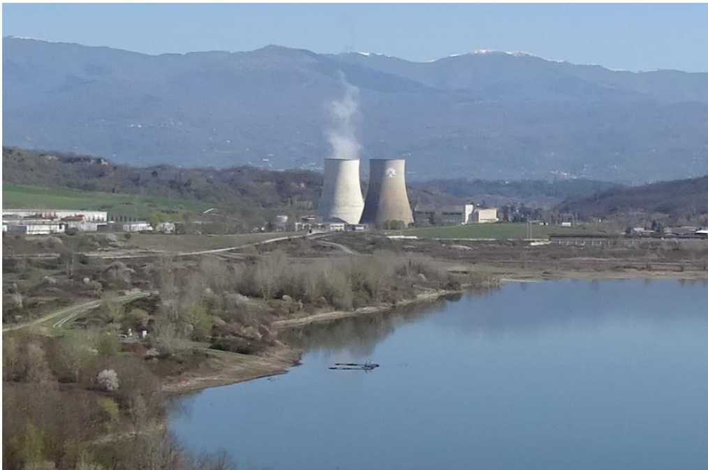
Figura 4.7.37 – Centrale Santa Barbara
