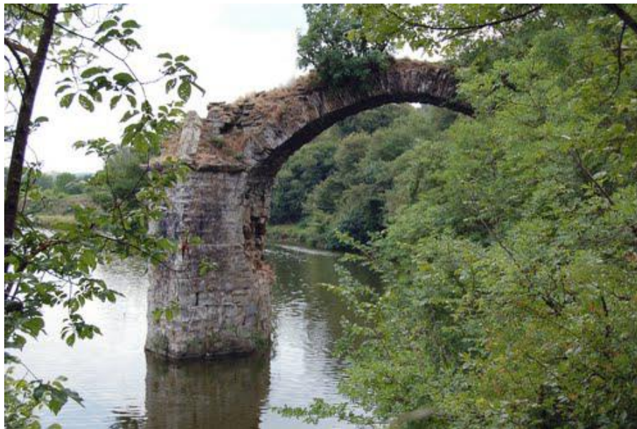
Figura 4.7.5 – Ponte del Romito sull'Arno
