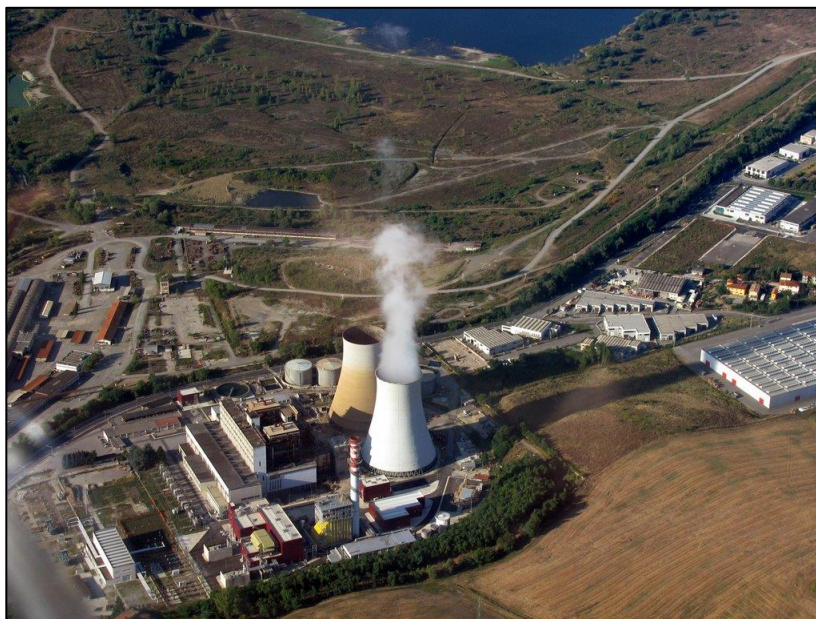
Figura 1.4.3 – Centrale Termoelettrica “Santa Barbara”
