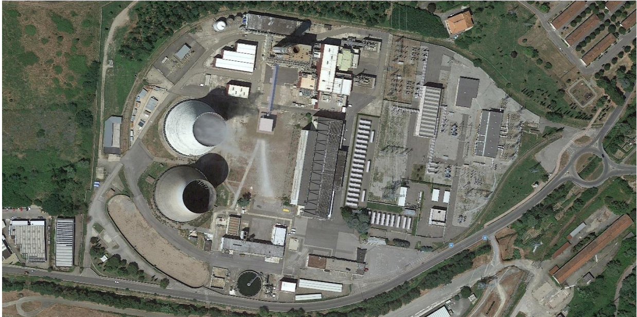
Figura 4.7.47 – Vista zenitale – Ante operam (con impianti BESS e TESS)
