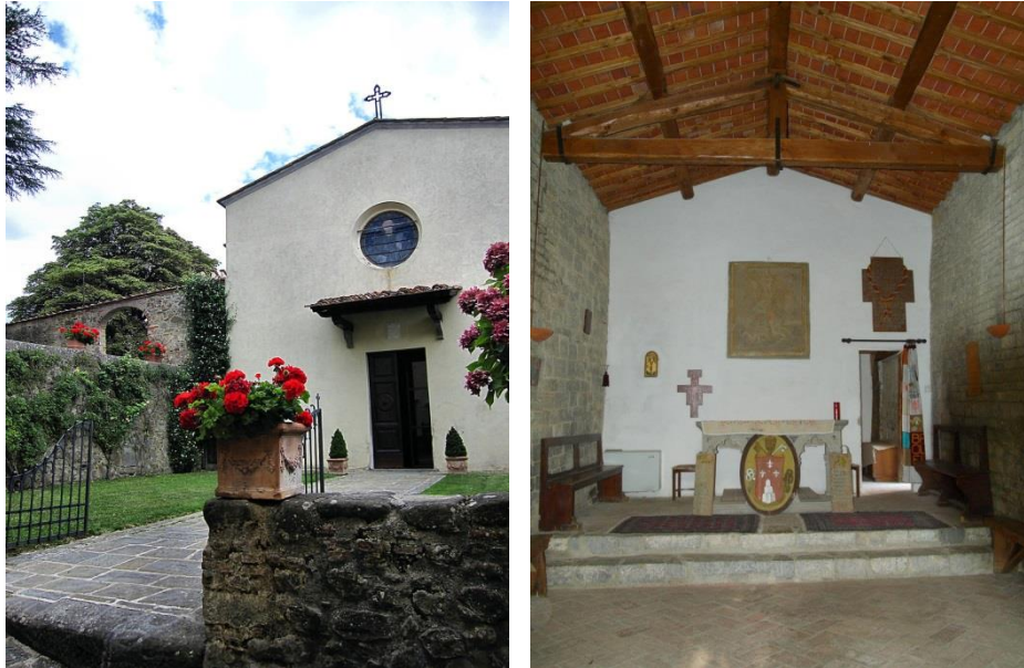
Figura 4.7.34 – Chiesa di San Pietro: facciata (a sinistra) e interno (a destra)
