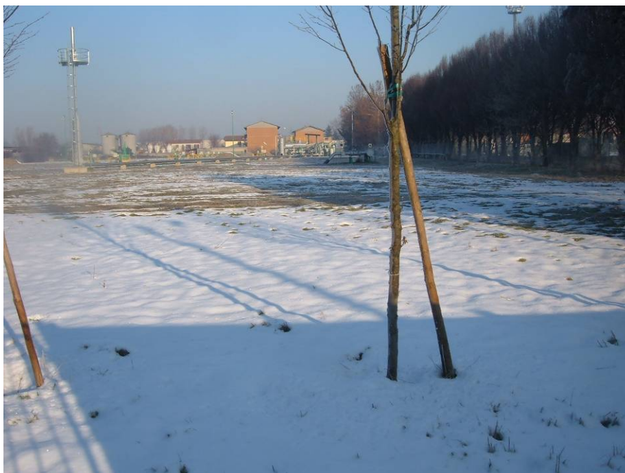
Da R2 verso l'impianto STOGIT
