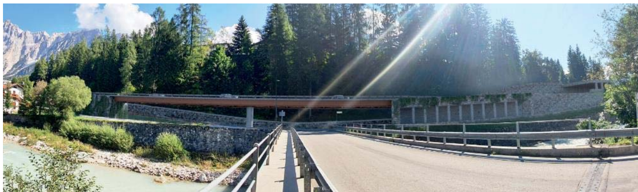
Figura 5.21 – Il viadotto di scavalco della Via Senes visto dalla strada per Serdes in corrispondenza del ponte esistente sul Boite
