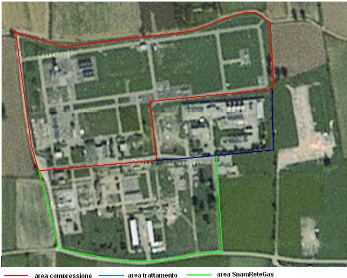
Fig. 1.1.a – Concessione Sergnano Stoccaggio: Centrale di stoccaggio, aree compressione ed erogazione
