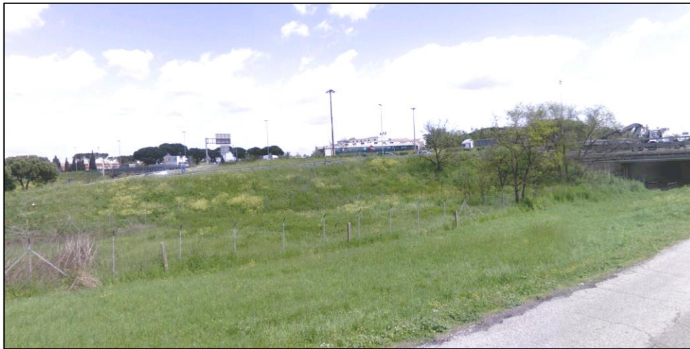
Figura 3 Rilevato Ramo 2 di Svincolo, da ampliare
