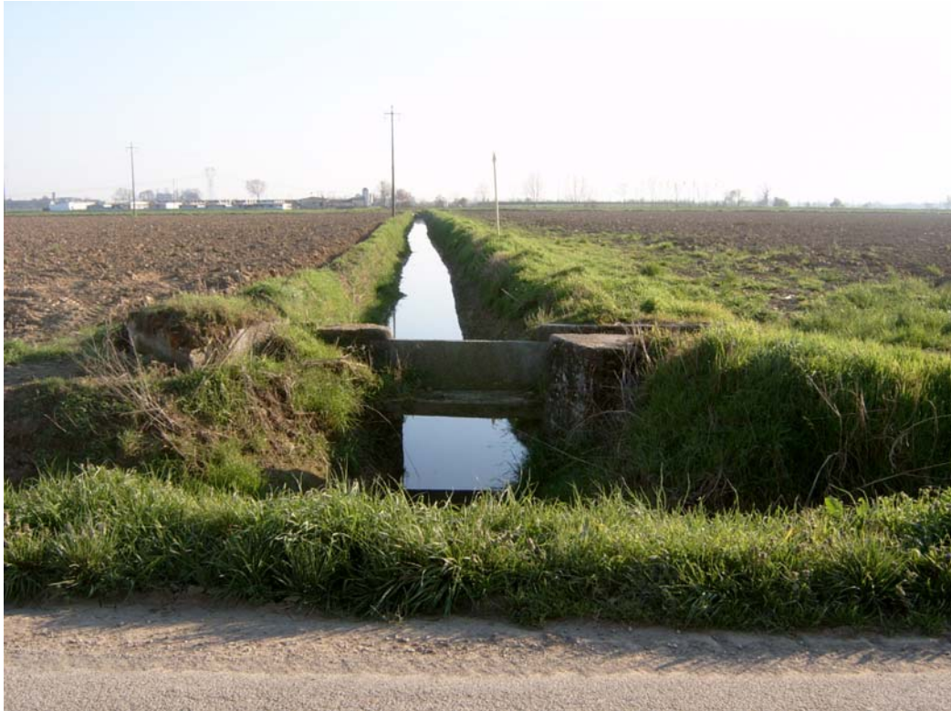
Fig. 4.2.1.1.b: Particolare fotografico della roggia Bordolana ripresi dallo spigolo NE dell'area di costruzione della nuova centrale
