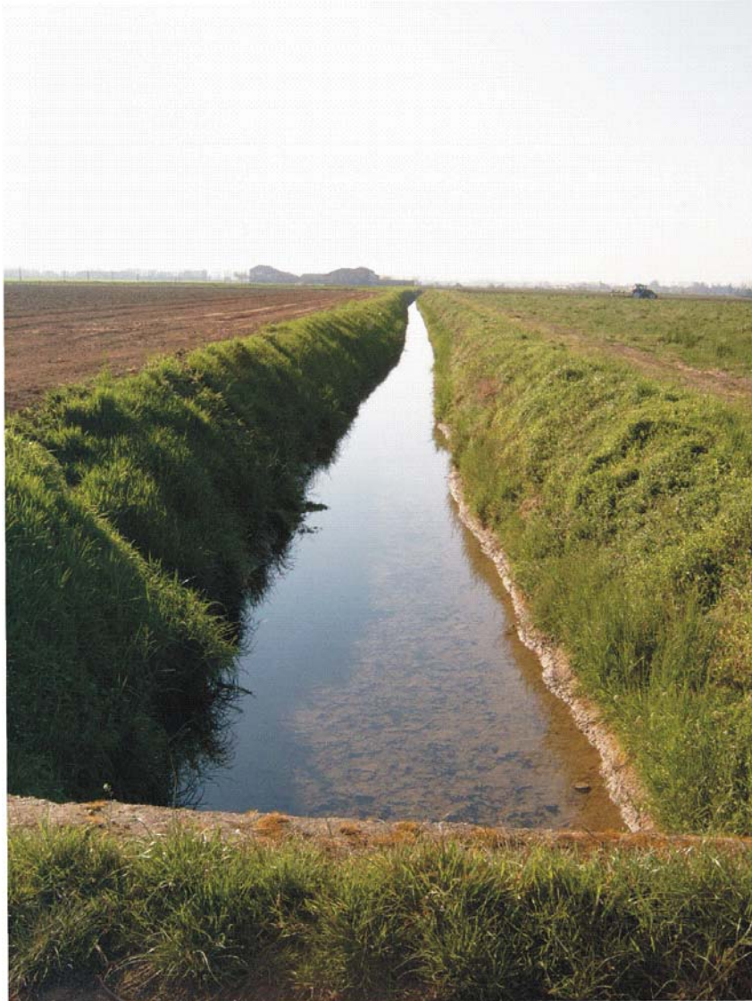
Fig. 4.2.1.1.d: Particolare fotografico della roggia Ponzone ripresa dallo spigolo SO dell'area di costruzione della nuova centrale
