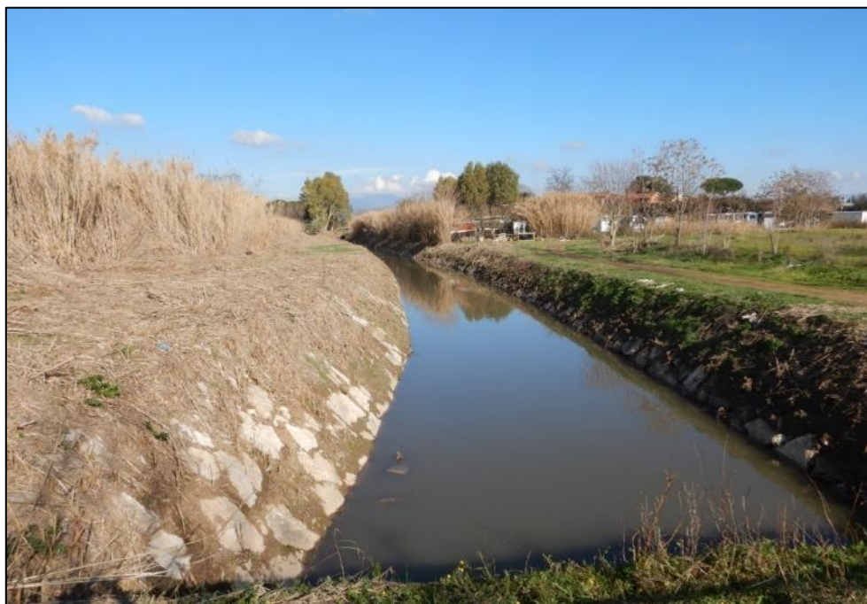
Figura 4: Tratto dell'alveo del Fosso di Pratolungo
