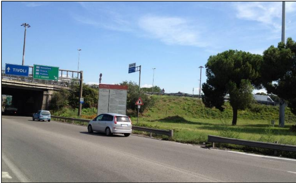
Figura 2: Rilevato del GRA in corrispondenza del sottovia esistente
