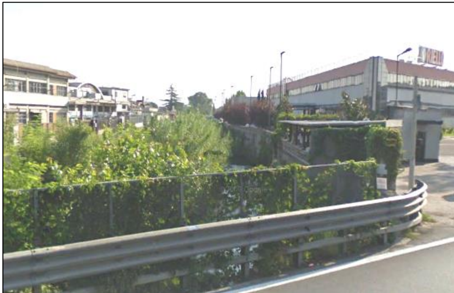
Figura 7: Fosso Pratolungo in prossimità del punto di confluenza nell’Aniene. Il corso d’acqua si trova ad essere confinato a seguito della realizzazione di interventi antropici
