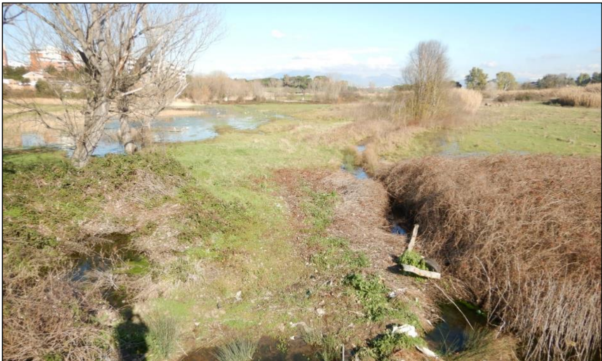
Figura 14: Evidenze di acque stagnanti nel canale in destra del Fosso di Pratolungo
