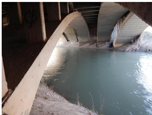
Figura 44: Vista delle spalle del ponte esistente sul fiume Aniene.
