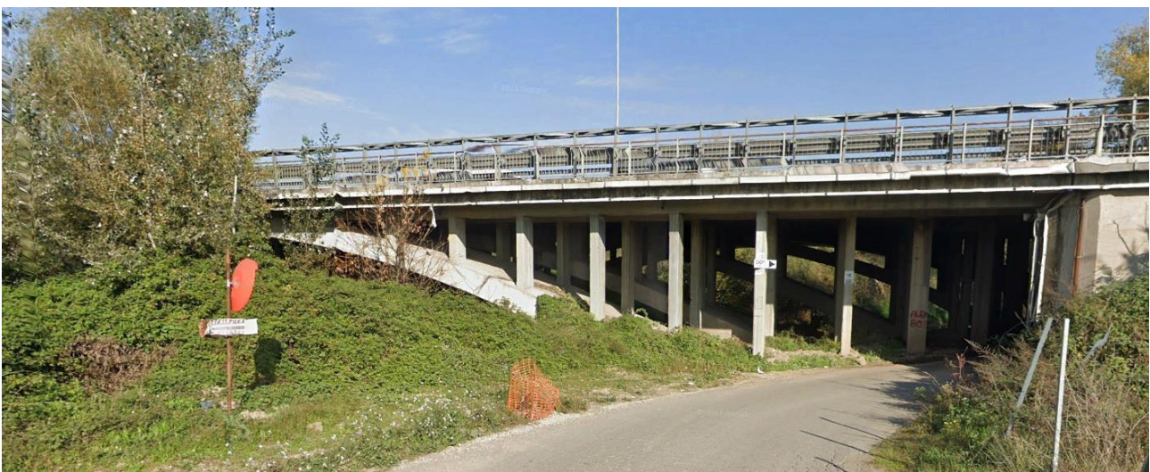
Figura 24: Vista da valle, dalla sponda sinistra del ponte esistente del GRA sul fiume Aniene
