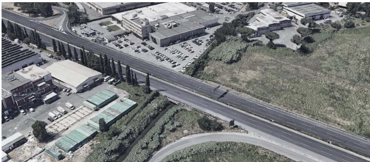
Ponte esistente sul Fosso di Pratolungo
