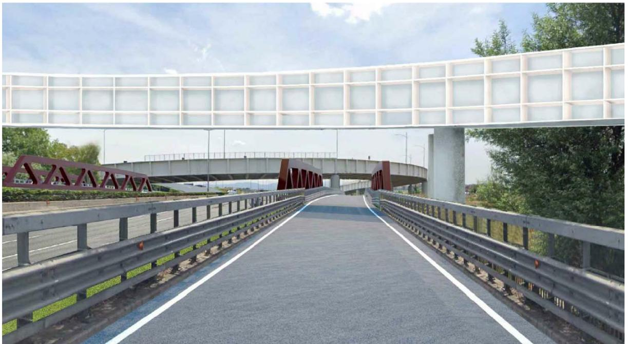
*Vista ravvicinata sull'asse dell'attuale GRA. Sullo sfondo il viadotto di scavalco A24, in primo piano il nuovo viadotto corrispondente simmetrico e sul campo medio i ponti di progetto sull'Aniene*
