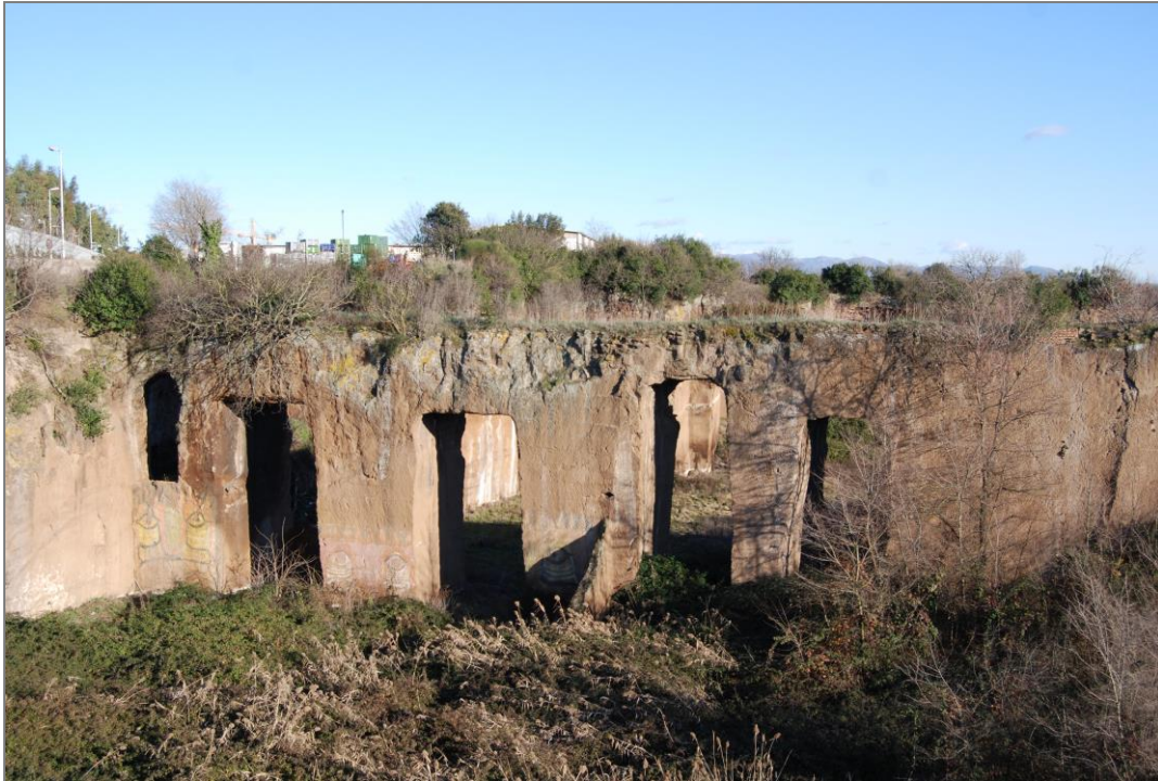
Figura 7 – La cava all'incrocio di Settecamini
