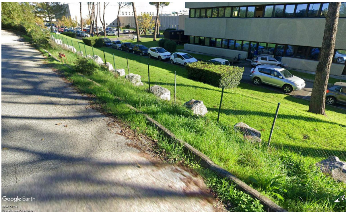
Figura 24 – Via Sabatino Gianni, lato uffici Mercedes-Benz, l'allineamento di blocchi di travertino
