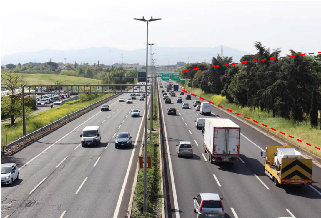
Figura 62 Punto 4 via Sabatino Gianni – esempio di impatto dovuto all'Eliminazione – stato ante operam
